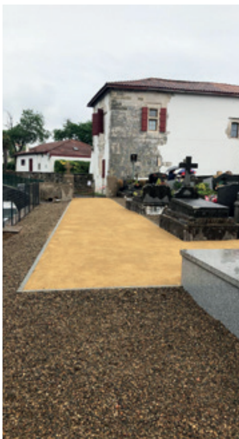
Mise en accessibilité du cimetière jusqu'à l'église
