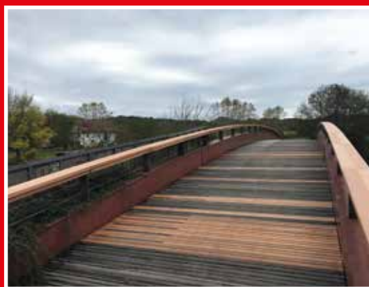
La Passerelle renovée réouverte
